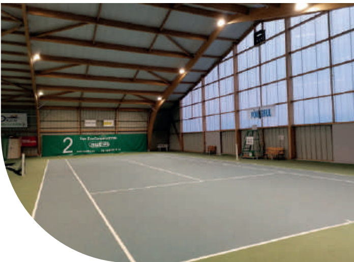
Mise aux normes éclairage du hall de Tennis
