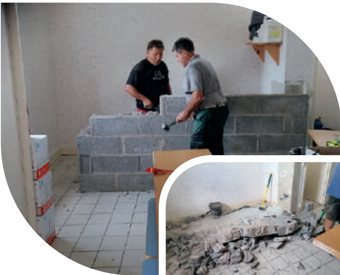
Travaux bureau de la directrice de l'école
